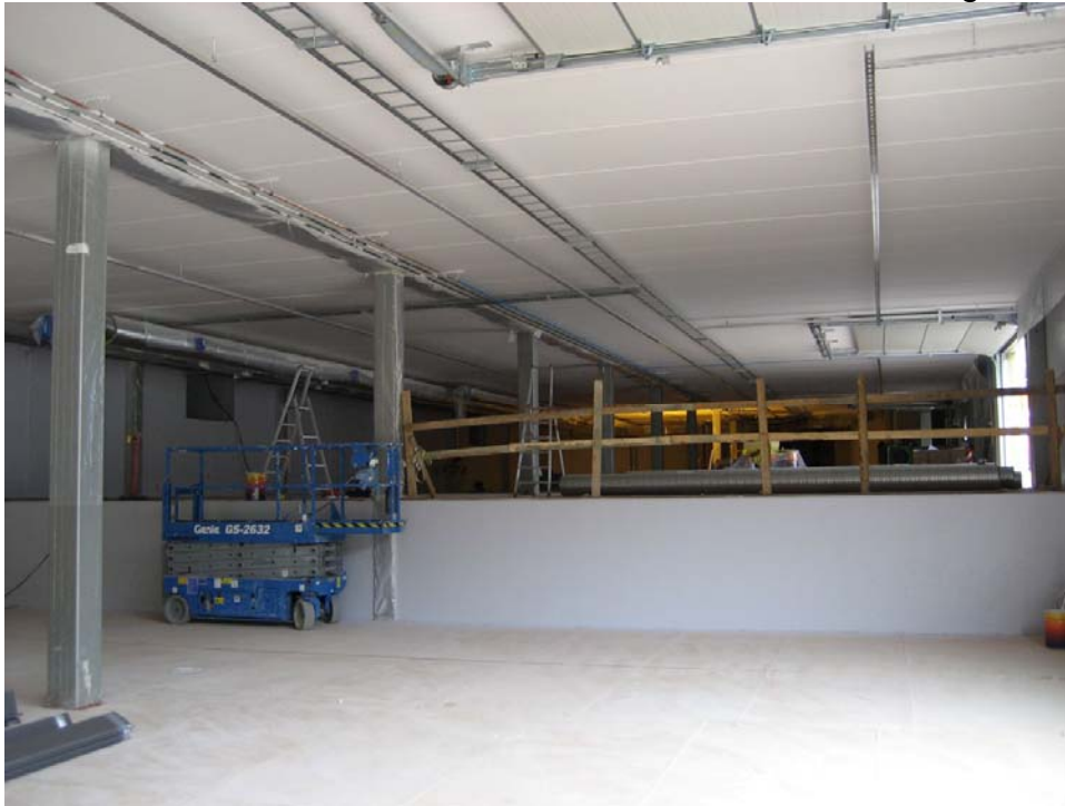
Uusi rakennus sisältä
